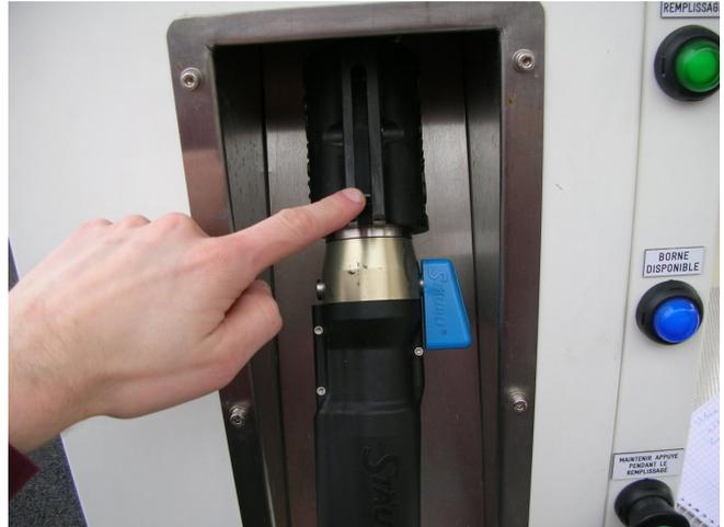
Die Kupplung wird einfach auf den Tankstutzen geschoben soweit es geht, und dann der Hebel nach rechts (zum Auto hin) gedreht. Jetzt kann man tanken.
